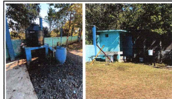
FOTO 6: Se observa el mal sistema de distribución de agua potable y el riesgo del tinaco de agua a la vista
